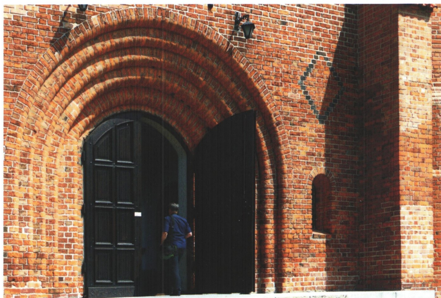
Fot. 3.2.3. Elewacja ceglana po konserwacji (widoczna dekoracja wykonana z cegły zendrówki)
