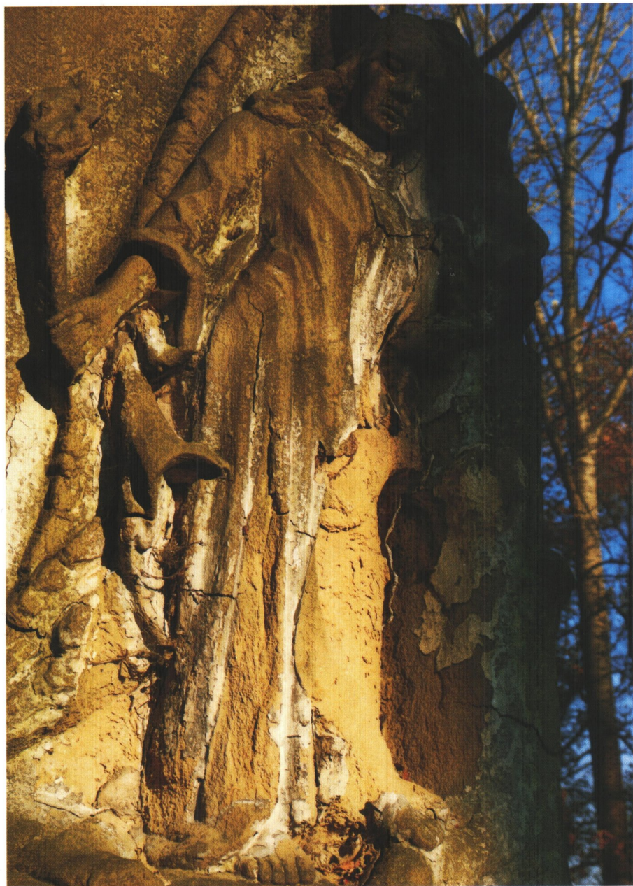
Fot. 1.2.1. Zniszczenia piaskowca powstałe na skutek działania czynników atmosferycznych
