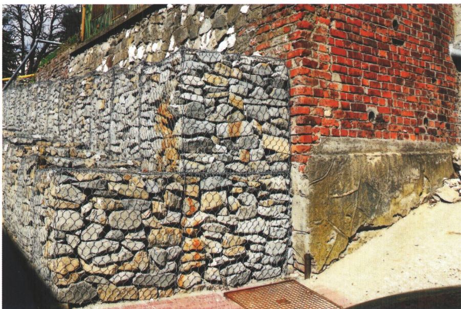
Fot. 2.1.1. Pomocnicza konstrukcja z gabionów wzmacniająca mur
