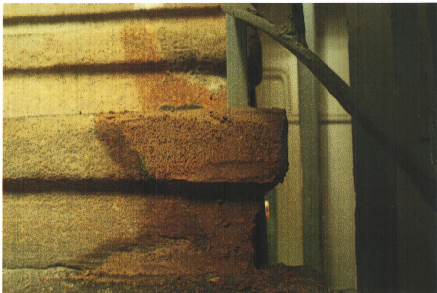
Fot. 4.3.9. Uzupełnianie ubytków w piaskowcu
