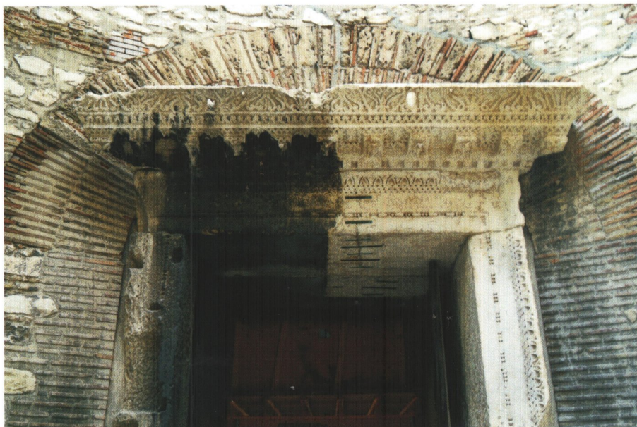
Fot. 2.4.4. Częściowo usunięta czarna patyna z powierzchni kamiennego portalu
