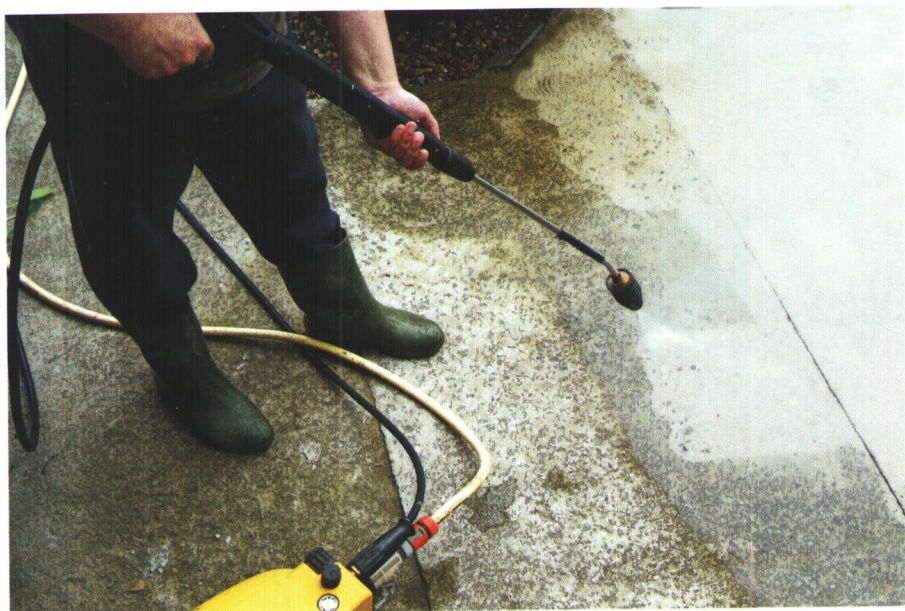
Fot. 2.4.6. Czyszczenie hydrodynamiczne
