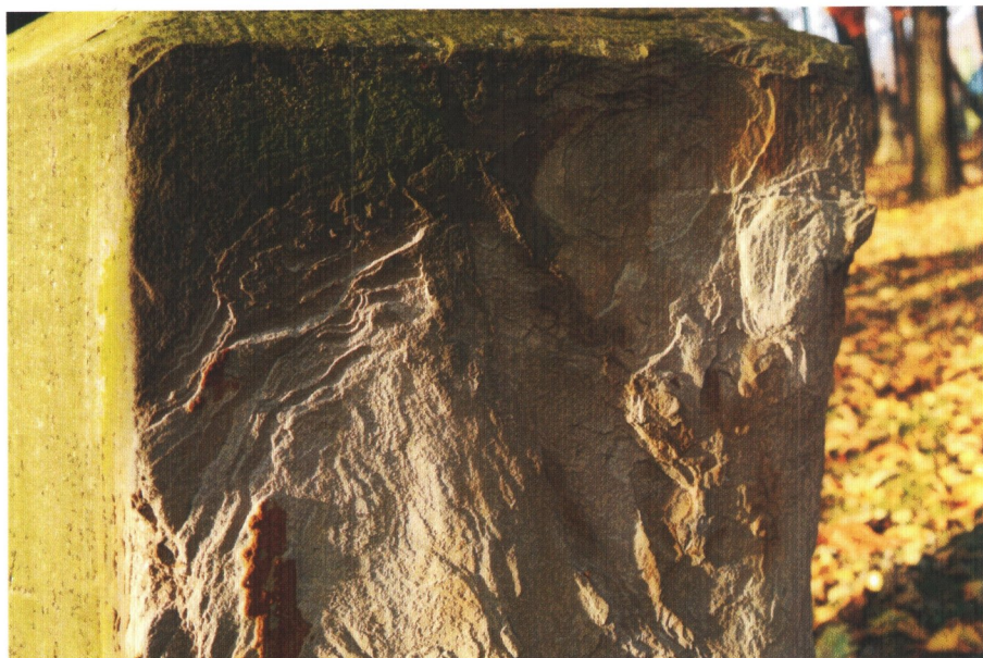
Fot. 1.2.2. Rozmyta przez wodę powierzchnia piaskowca
