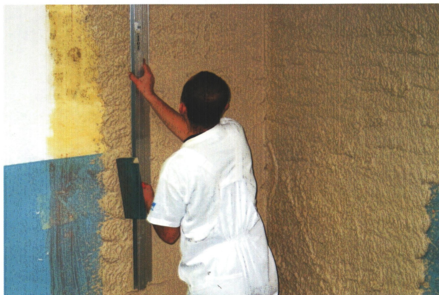
Fot. 3.3.6. Tynkowanie tynkiem gipsowym maszynowym
