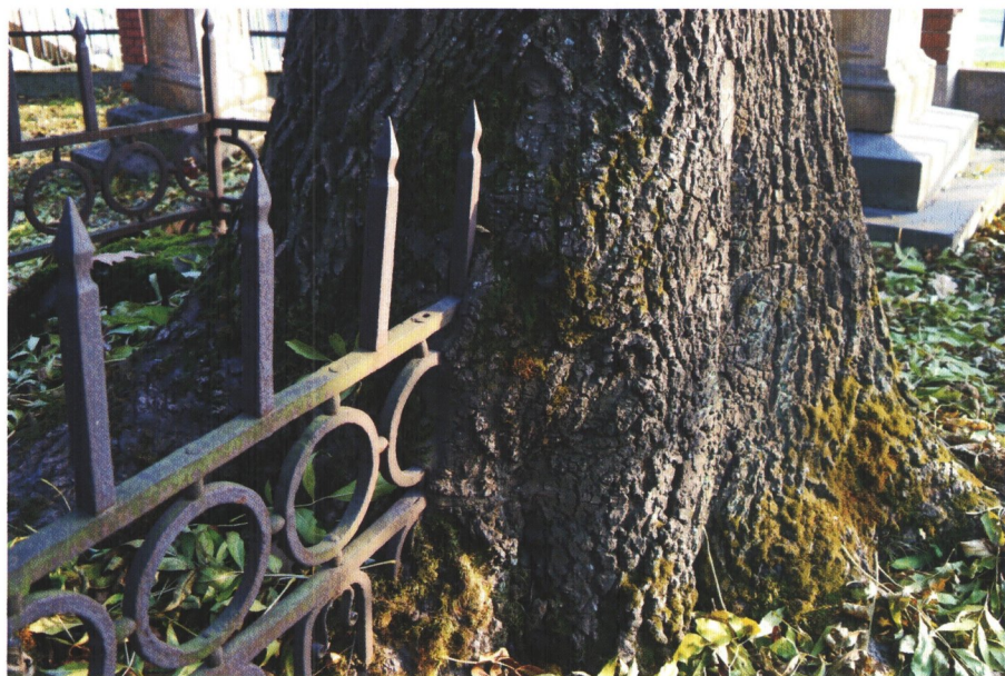
Fot. 1.2.5. Zniszczenie zabytkowego ogrodzenia przez rozrastające się drzewo
