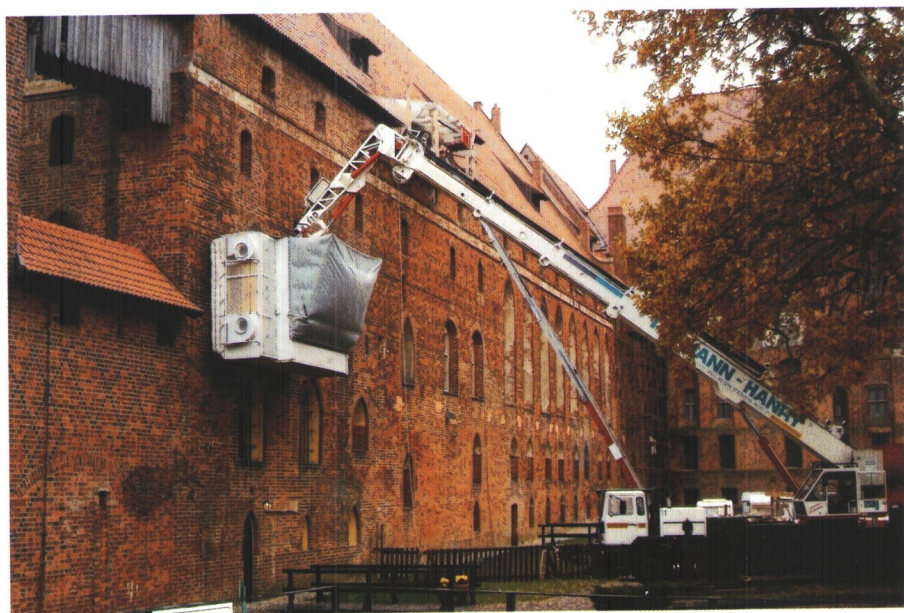
Fot. 2.4.7. Zamek krzyżacki w Malborku - czyszczenie murów ceglanych metodą Le Gémimage® [fot. Thomann-Hanry® 2010]
