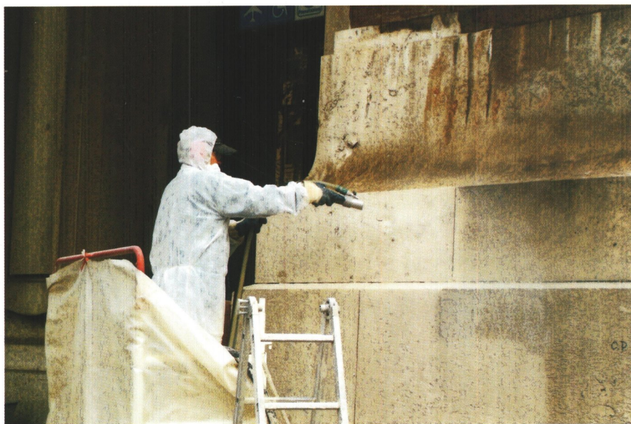
Fot. 2.4.5. Dworzec w Mediolanie podczas czyszczenia metodą piaskowania [fot Giovanni Dall'Orto 2007 wikimedia org]
