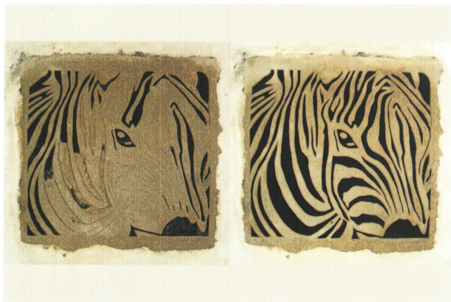
Fot. 4.1.1. Tynk ozdobny sgraffito – w trakcie wykonywania i efekt końcowy
