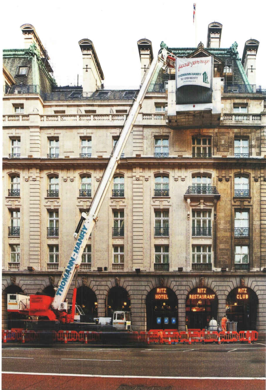
Fot. 2.4.9. Hotel Ritz w Paryżu podczas oczyszczania fasady metodą Le Gommage® [fot Thomann-Hanry® 2011]
