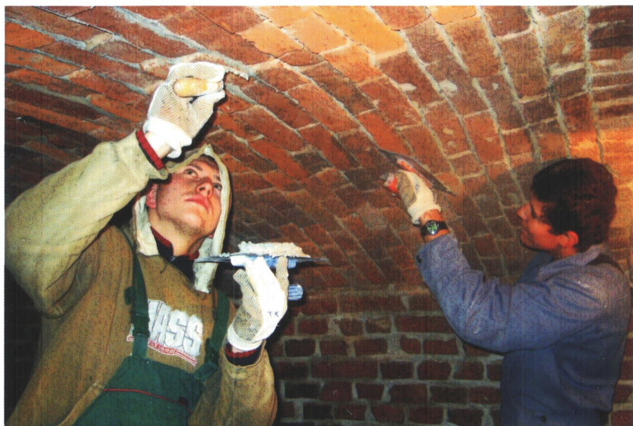
Fot. 3.2.4. Spoinowanie sklepienia ceglanego [fot. Jan Urbanek 2006]
