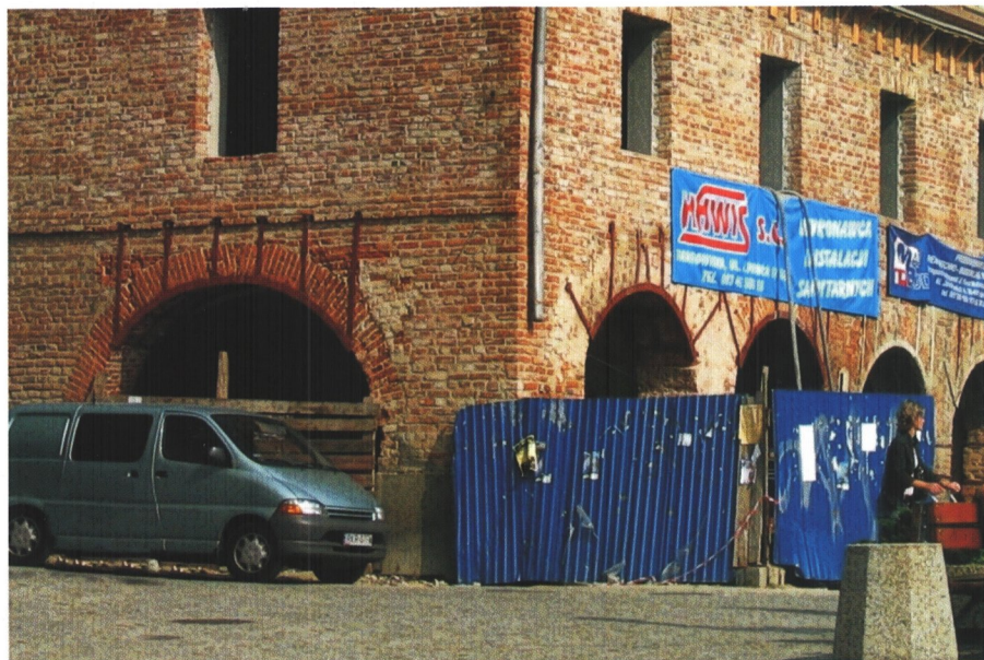
Fot. 3.2.2. Wzmocnienie łuków metalowymi klamrami
