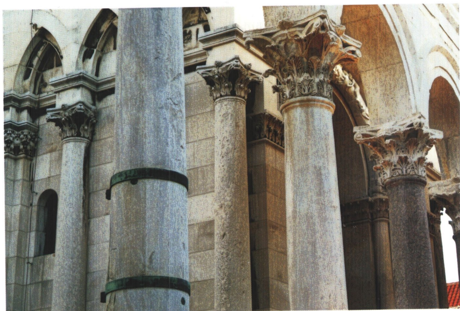
Fot. 2.1.2. Obejmy metalowe stabilizujące trzon kolumny
