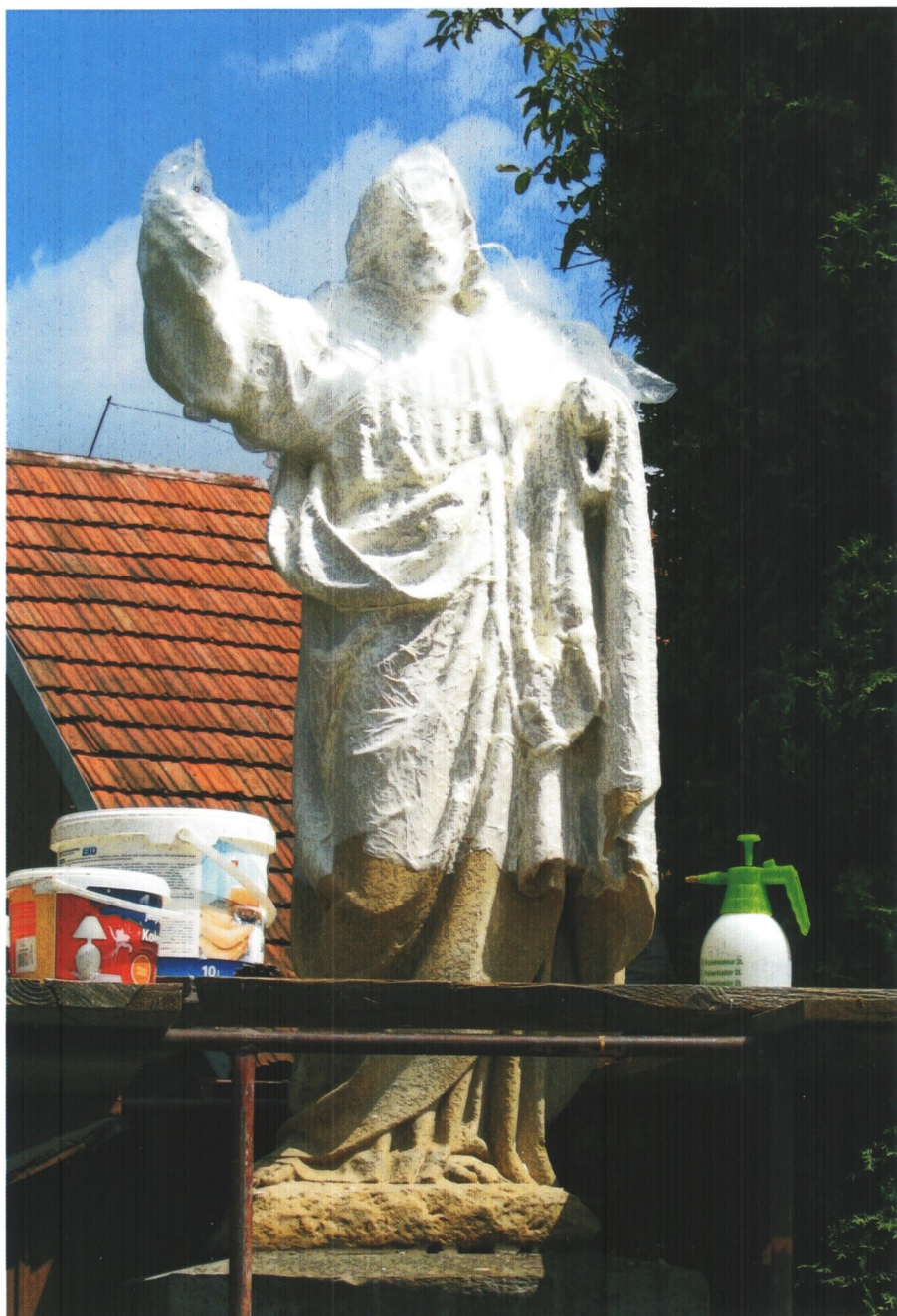
Fot. 2.4.9. Odsalanie rzeźby z piaskowca metodą swobodnej migracji soli do rozrzedzonego środowiska (kompresy z waty celulozowej)
